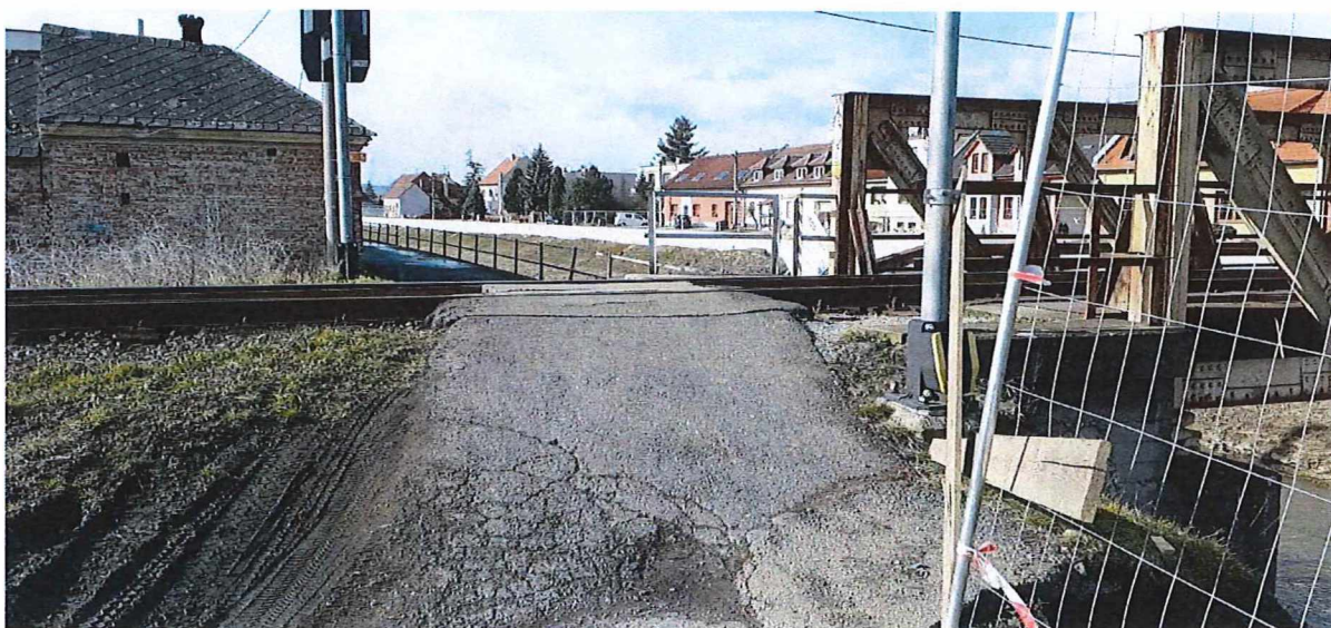
Obrázek č. 17 - Km 100,312 - přechod P7959 - přejezdem prochází pojistné úhelníky
