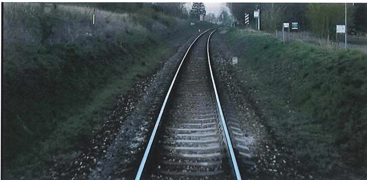
Obrázek č. 6 - Km 97,150 – zářez – znečištěné kolejové lože
