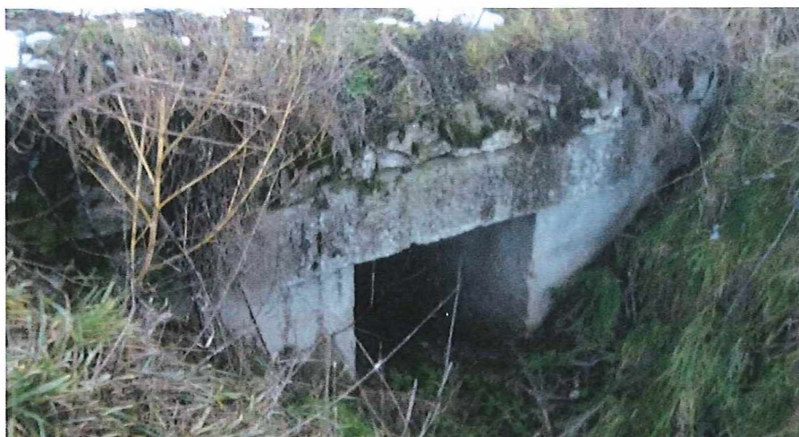
Obrázek č. 10 - Km 98,614. - Propustek Kamenný, deskový o světlosti 1,0m, z roku 1887
