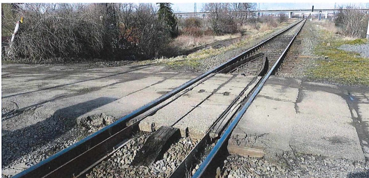
Obrázek č. 19 - Km 100,338 - přejezd P7960 – přejezdem prochází pojistné úhelníky
