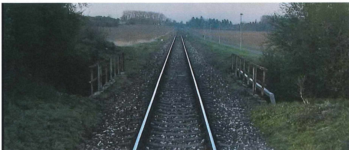
Obrázek č. 9 - Km 98,290 – Most s průběžným kolejovým ložem – absence odvodnění
