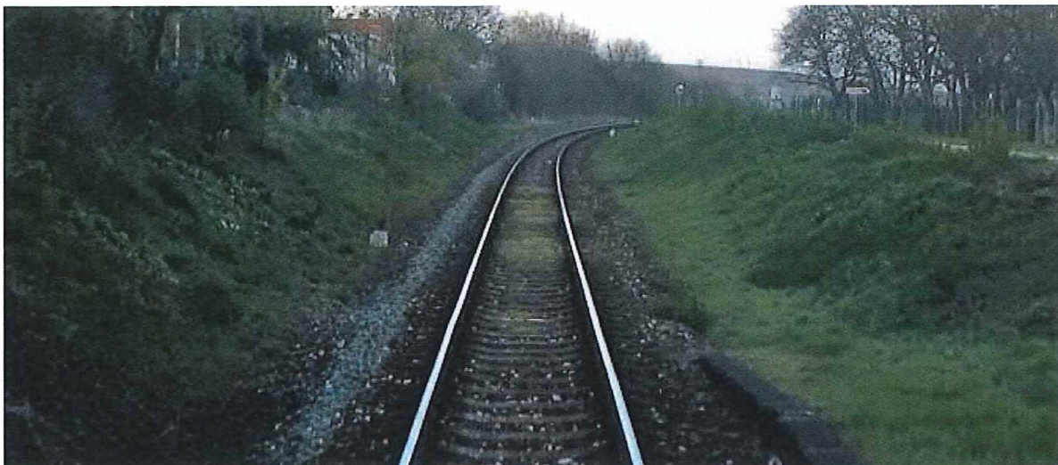
Obrázek č. 12 - Km 99,200 - Zářez – znečištěné kolejové lože
